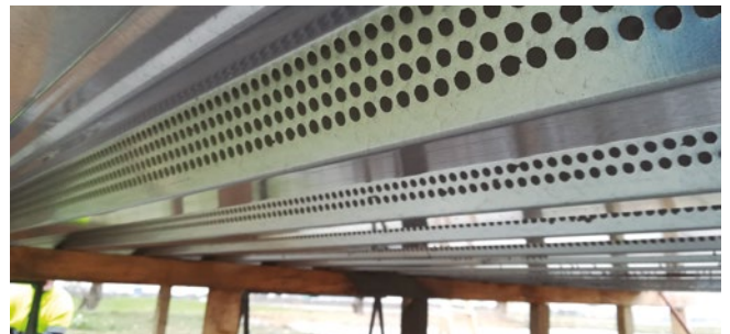
Imágenes correspondientes al ensayo en fase de hormigonado.
