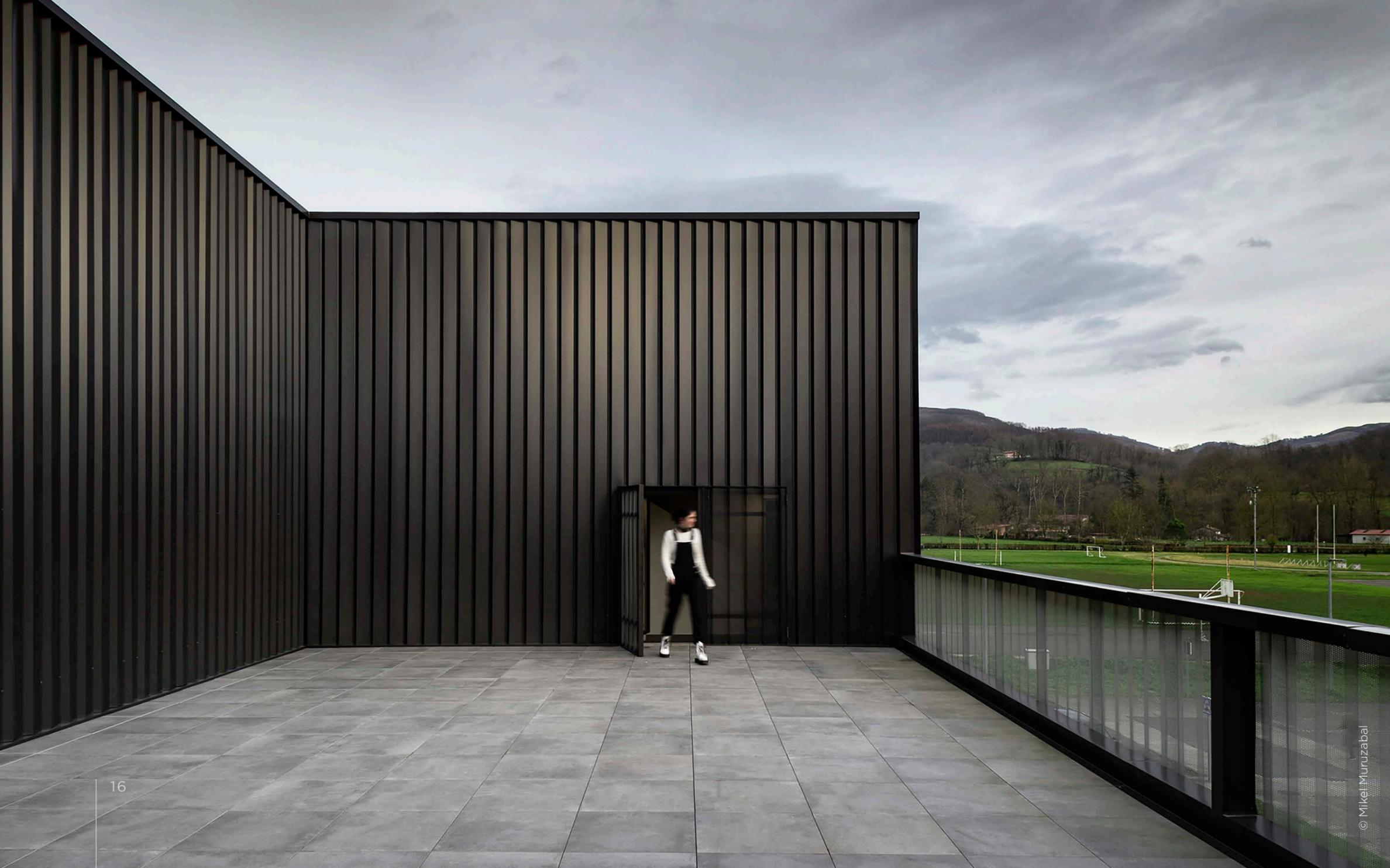
El perfil ATENEA se distingue por su sucesión de ondas inclinadas y regulares con efecto de lama capaces de crear fachadas llenas volumen y movimiento gracias a su geometría angular.
