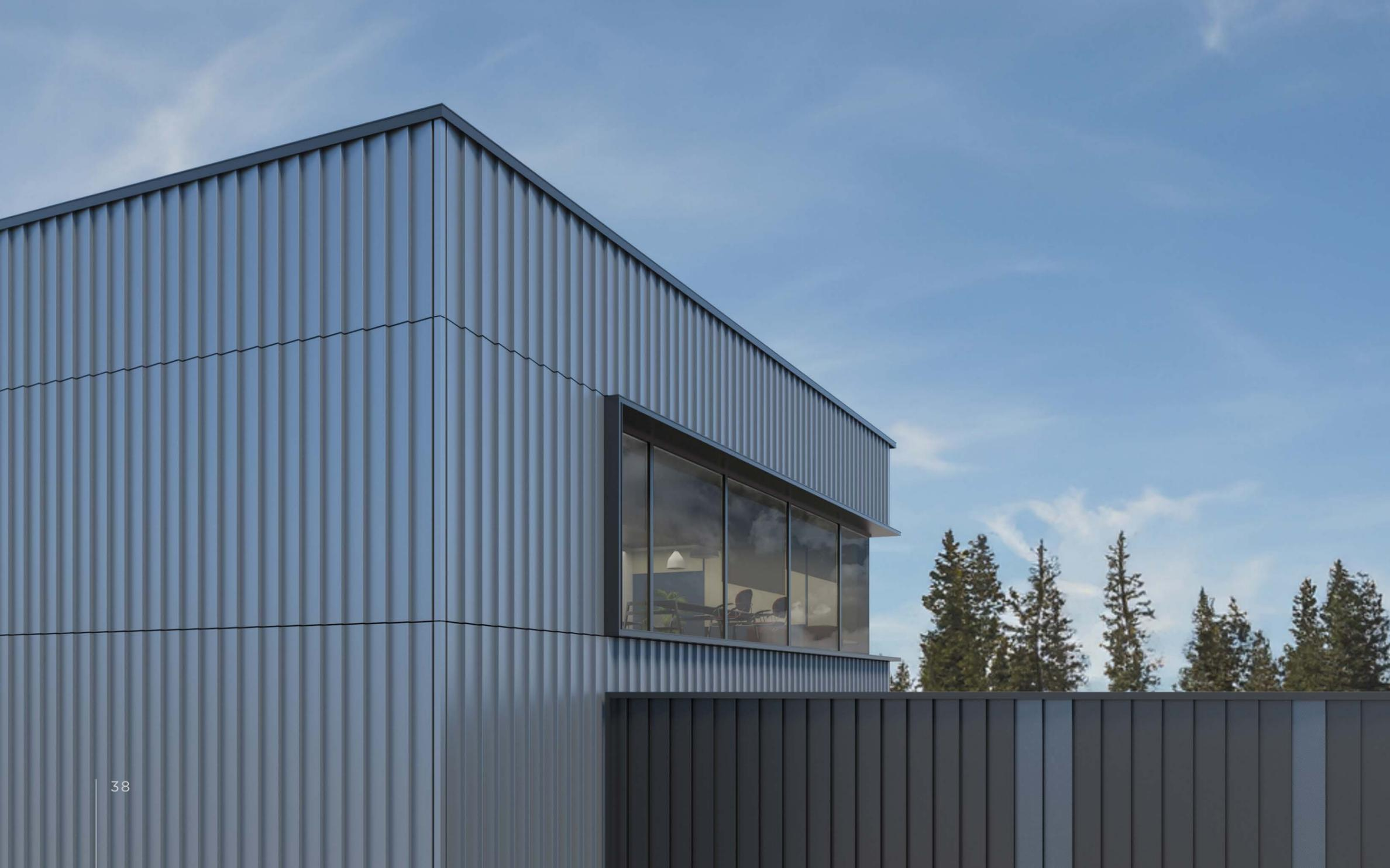
AXIOS es una lama inclinada que crea secuencias repetitivas en fachada aportando volumen y movimiento. Gracias a su geometría angular de alto canto, según el punto de vista desde el que se observe parece una superficie completamente lisa.
