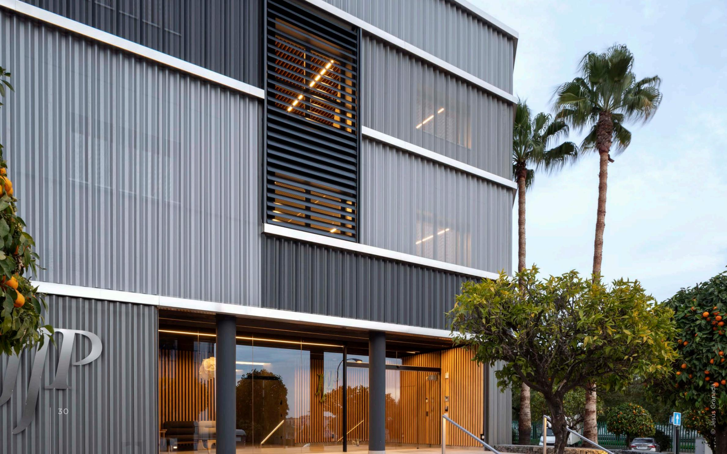
El perfil GIZA es una lama de geometría regular y piramidal de canto alto que genera en la fachada estética cambiante. Los diferentes planos ofrecen un interesante juego de tonalidades. Permite solaparse longitudinalmente con todos los perfiles de fijación oculta.
